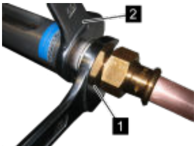
Abb. 11: Gerät einschrauben
