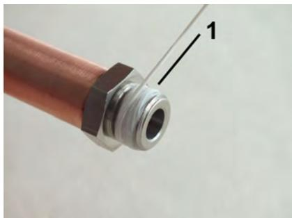
Abb. 9: Dichtfaden aufbringen
